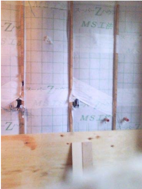
壁のセルロースファイバー吹き込み
