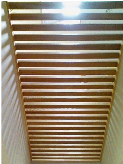
2階の床に設置した格子を1階から見上げる
